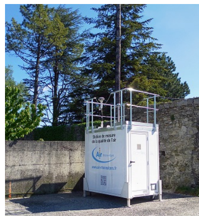
Station de mesure de la qualité de l'air
